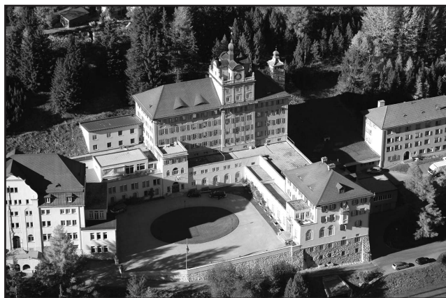
Instalaciones del Lyceum Alpinum Zouz
